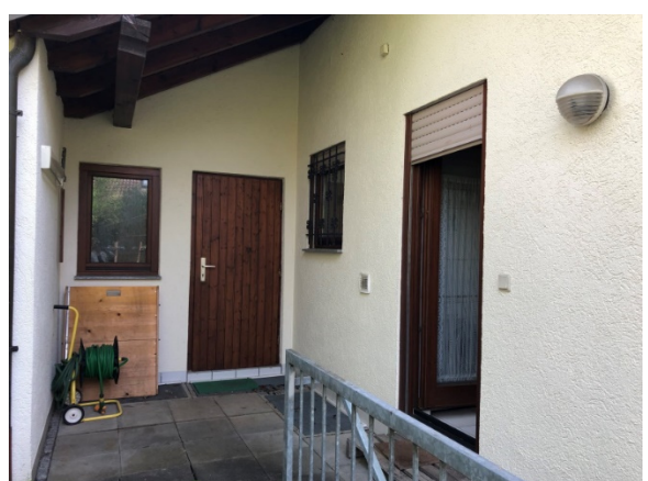
Rückwärtiger Zugang Garage
