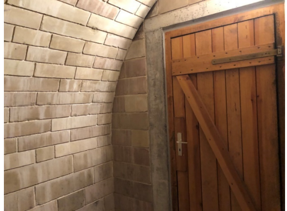
UG Eingang Gewölbekeller
