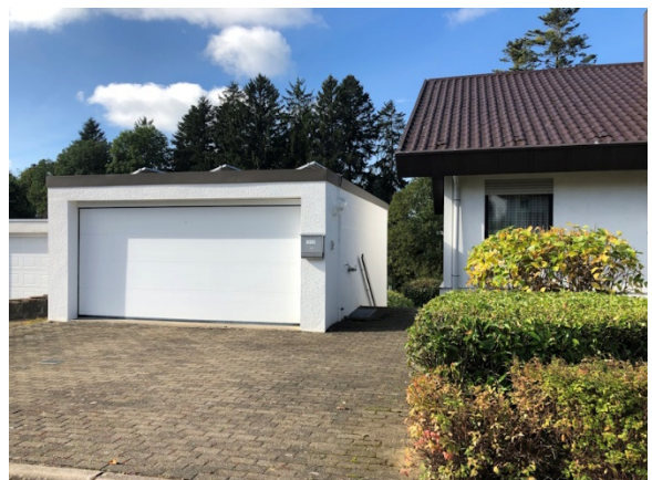
Doppelgarage, Dach mit PV-Anlage
