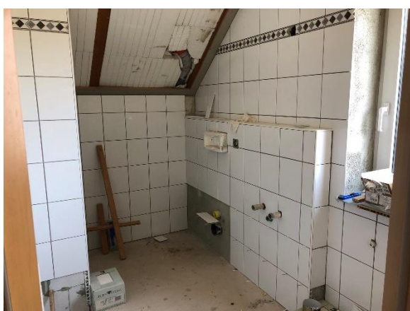
DG Bad zum weiteren Ausbau
