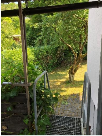
EG Terrasse, Zugang Garten
