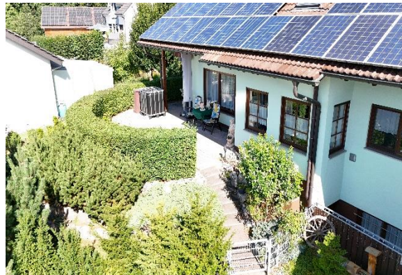
Ansicht Süden, Terrasse
