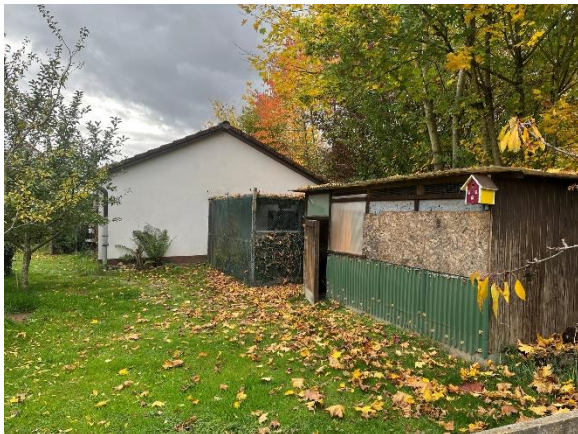
Anbau Garage u. Gartenhütte
