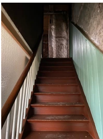
EG Treppe ins OG
