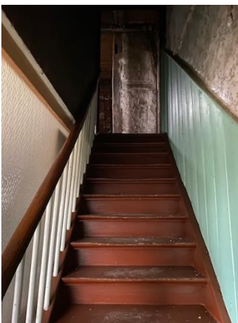
EG Treppe ins OG
