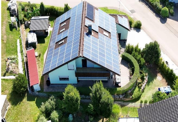
Ansicht Dach, Solar u. PV
