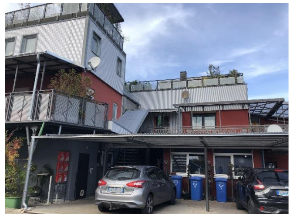
Carport u. Eingang
