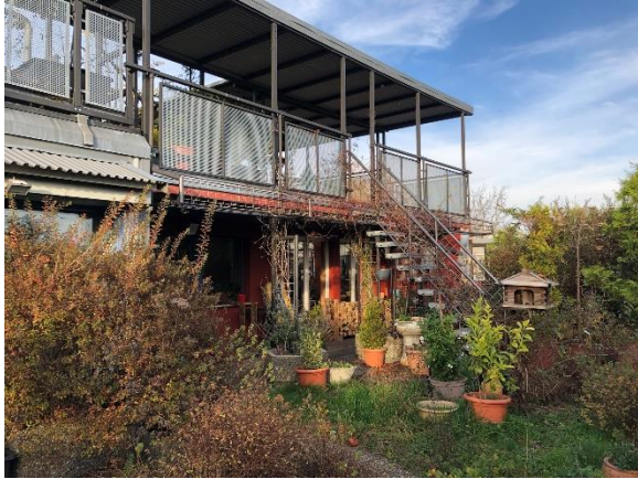
1.Dachterrasse, Zugang Treppe zur 2.Dachterrasse
